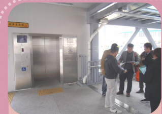
工程團隊與觀塘區議員實地視察安泰邨的升降機各層大堂
