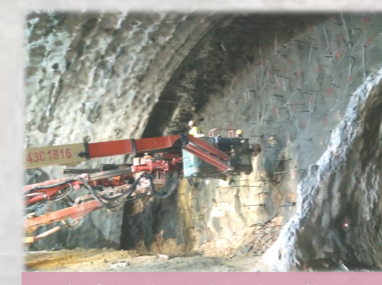
行車隧道工程採用格子桁及噴漿混凝土的臨時工程方法
