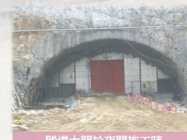
隧道大門於夜間施工時關閉以阻隔噪音
